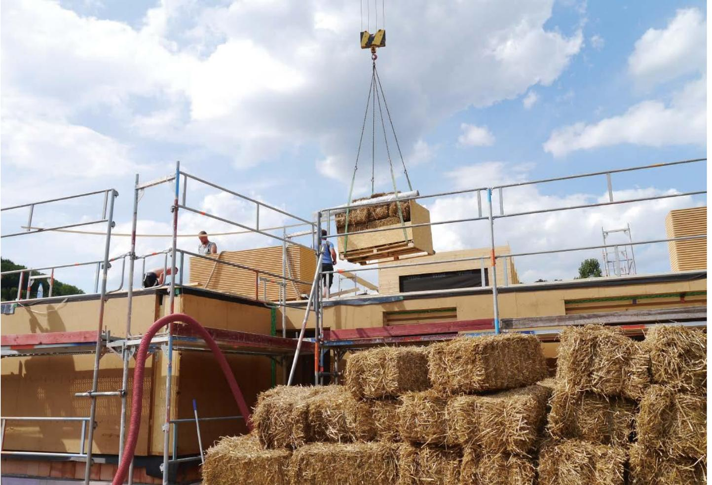
Circa 1.200 Strohballen wurden als Dämmung in die Holzständerkonstruktion der Außenwände und für das Sparrendach eingebaut.
