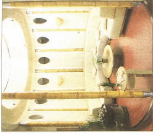
Funktional und dekorativ zugleich sind die 33 Bambus-Stützen, die das einstöckige Bürogebäude in Darmstadt tragen. Bambuspfeiler umrahmen die Rotunde mit Sitzgruppe im Inneren – so entsteht eine freundliche Raumatmosphäre. Fotos: Shakti Haus
