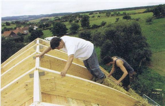
Mit dem Sparrenabstand von einem Meter und dem Sparrenmaß 6/30 waren auch die Dachsparren vorbereitet. Die Strohballen wurden einfach in die Gefache gelegt und gegenseitig verspannt
