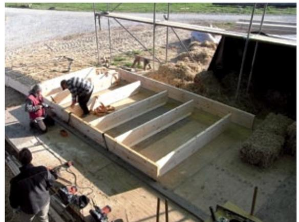
2. An den vertikalen Elementen – den Ständern sind bereits seitlich Klemmleisten angebracht (siehe Seite 33). Die Verbindung der Ständer mit Rähm und Schwelle erfolgt hier mittels Holzbauschrauben, welche diagonal zur Faserrichtung der Ständer eingebracht werden.
