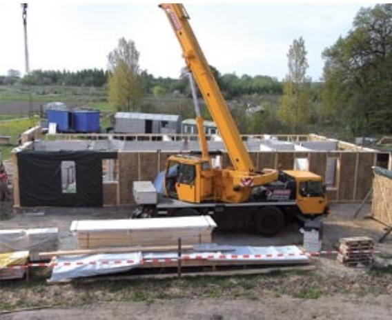
2. Aufstellen der letzten Wand im Erdgeschoss. Befestigungs- und weitere Nebenarbeiten folgen, Regenschutzplanen werden angebracht. Die Decke wird hergestellt, massive Innenwände werden gemauert. Dauer ca. 14 Tage.
