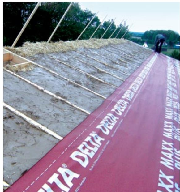
Dachstrohbauten mit Lehmputzlage und Unterspannbahn
