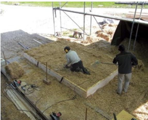
11. Nachrasieren der Oberfläche mit Heckenschere oder Elektrokettensäge.
