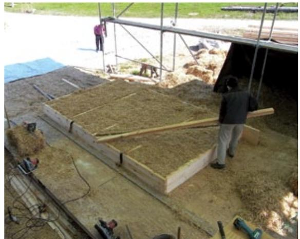
13. Einbau der oberen Klemmleisten.
