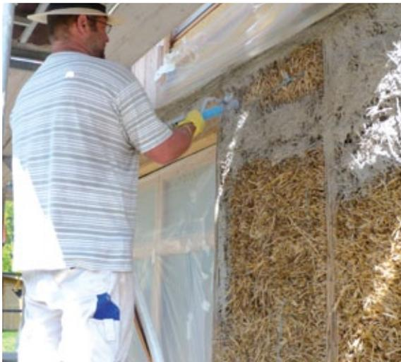
Erste Lage Luftkalkputz außen. Holzteile hier mit Putzträger aus Schilfrohr belegt.
