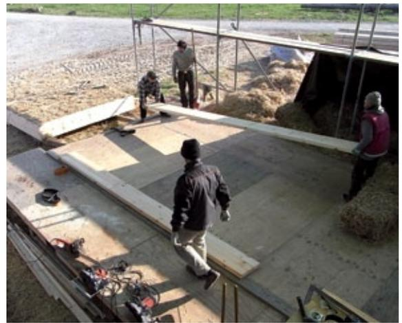
1. Montagetisch unter einem provisorischen Vorfertigungsdach neben der Baustelle. Die ersten Holzteile einer ca. 2,8 x 4 m großen Wand werden ausgelegt: unteres Rahmenholz, Schwelle und oberes Rahmenholz.
