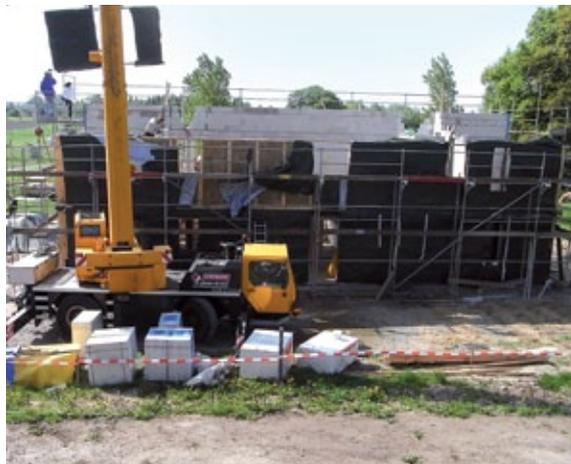
4. Aufstellen der letzten Wand im Obergeschoss. Befestigungs- und weitere Nebenarbeiten folgen, sowie Regenschutzplanen werden angebracht.
