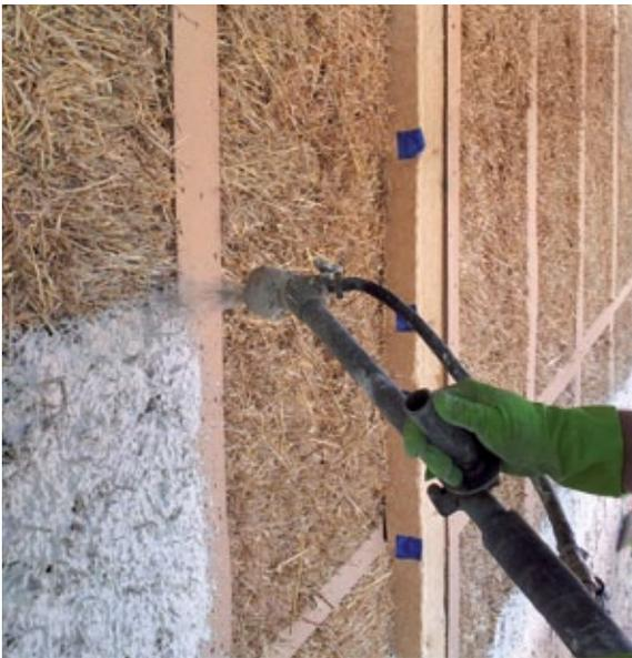
*Auftragen einer Kalkputzschicht auf die Strohdämmung mittels Putzmaschine*
