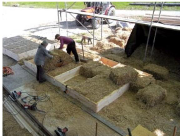
8. Lückenloses Einsetzen des zweiten Endballens neben dem ersten mittels Gleitplatten.
