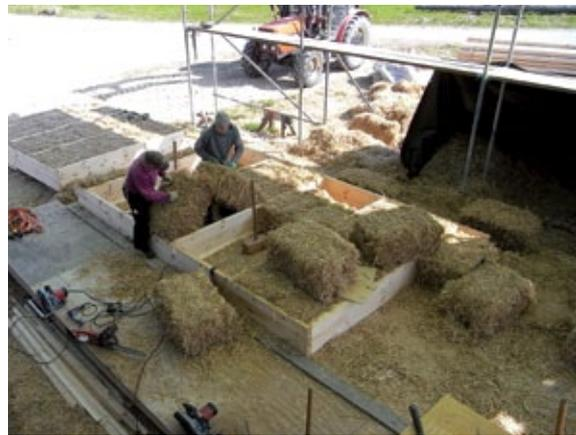
7. Einbau des ersten Endballens: Die notwendige Vorkomprimierung wird durch verkipptes Eindrücken überlanger Ballen erreicht.
