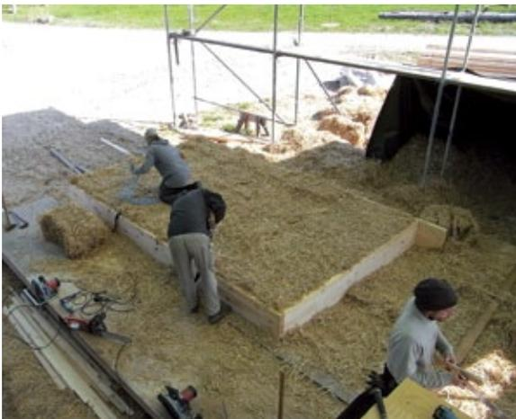
10. Nachstopfen von verbliebenen Lücken, Entfernen von Ballenschnüren (nur beim gezeigten aufrecht stehenden Einbau der Ballen möglich).
