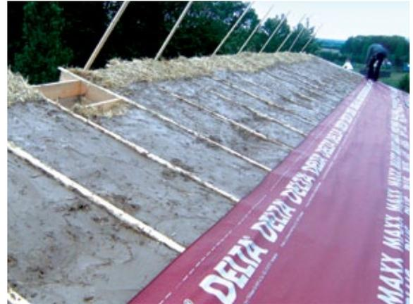
5. Dachstrohballe mit Lehmputzlage und Unterspannbahn.
