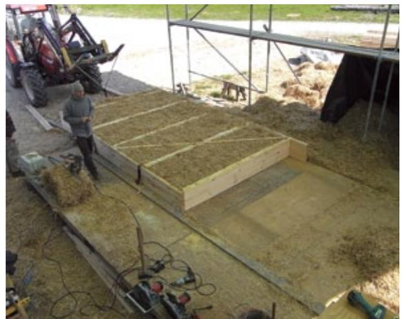
14. Fertiges Wandteil. Herstellungsdauer ca. 4 Stunden.
