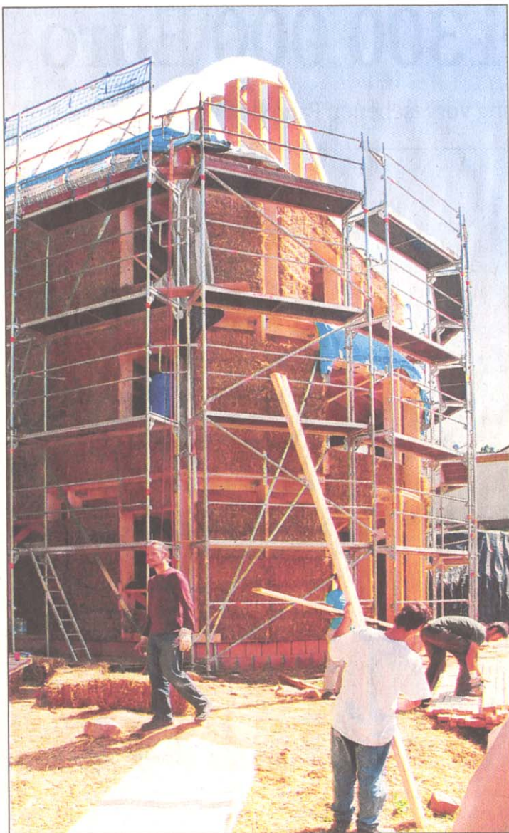
Das Erste seiner Art in Hessen: In Fürstengrund entsteht ein Strohballen-Haus. FOTO: HORST KAMKE
