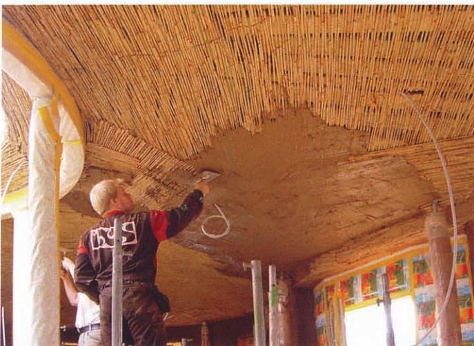
Hanfmatten der Dachunterseite werden mit Lehm verputzt
