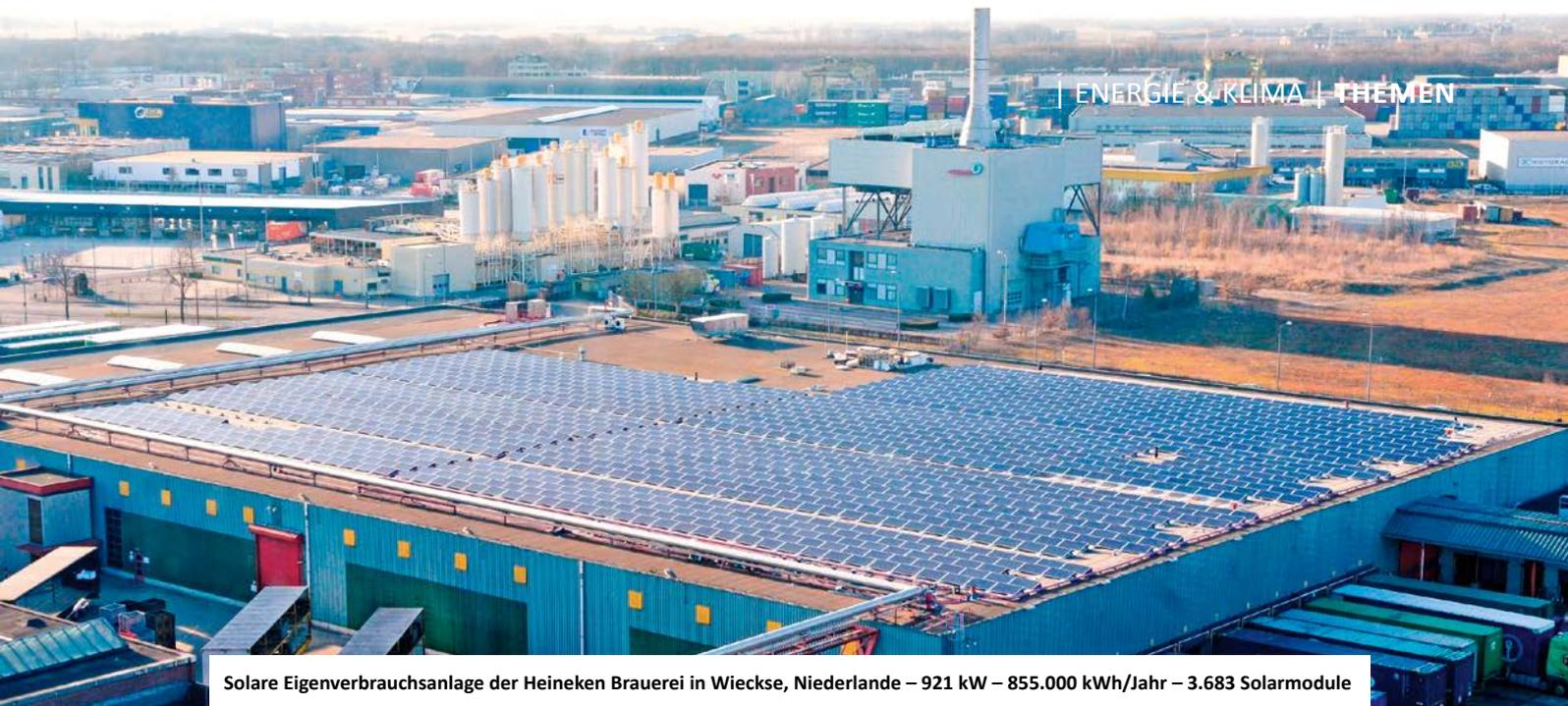
Solare Eigenverbrauchsanlage der Heineken Brauerei in Wierckse, Niederlande – 921 kW – 855.000 kWh/Jahr – 3.683 Solarmodule
