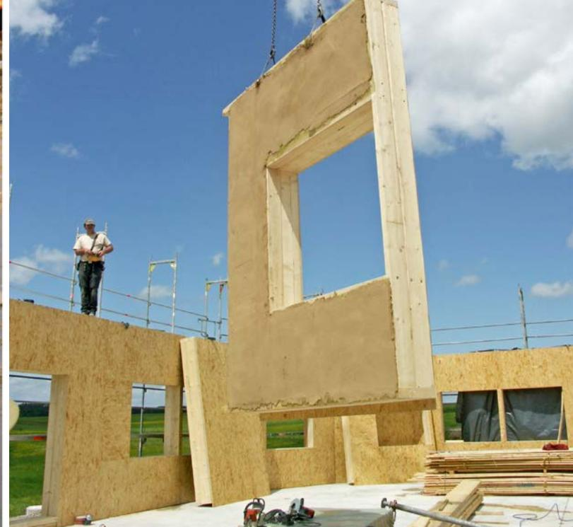
**Stroh Häuser in Holzständerbauweise: Die Bauteile können bequem und wettergeschützt in der Halle vorgefertigt und auf der Baustelle zusammengesetzt werden.**
