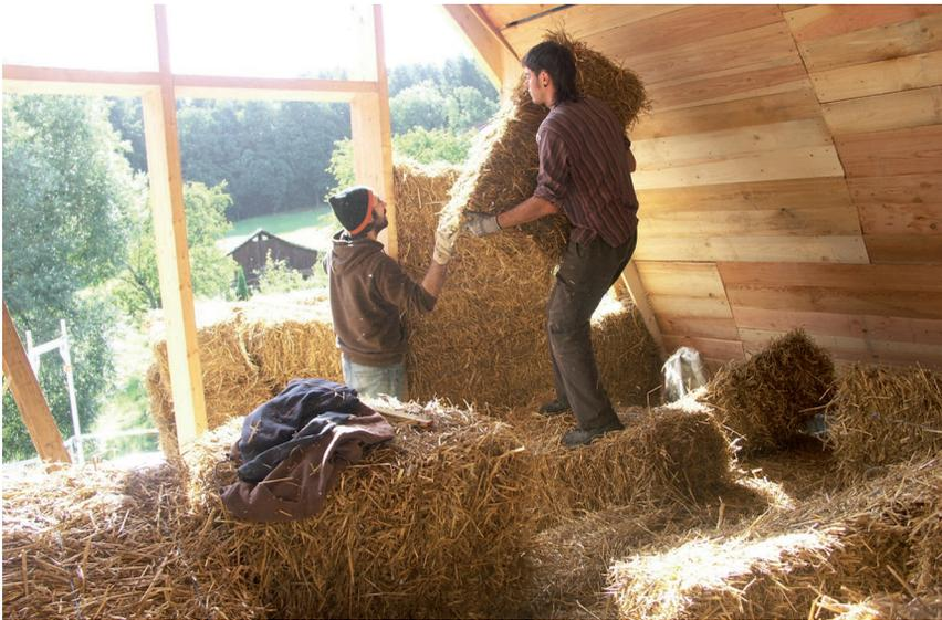
Einbau der Strohballen im Dachgeschoss
