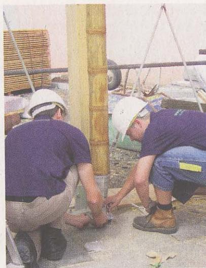
Die Montage der Bambusstützen beim Bambushaus. Fotos (2): Shaktihaus
