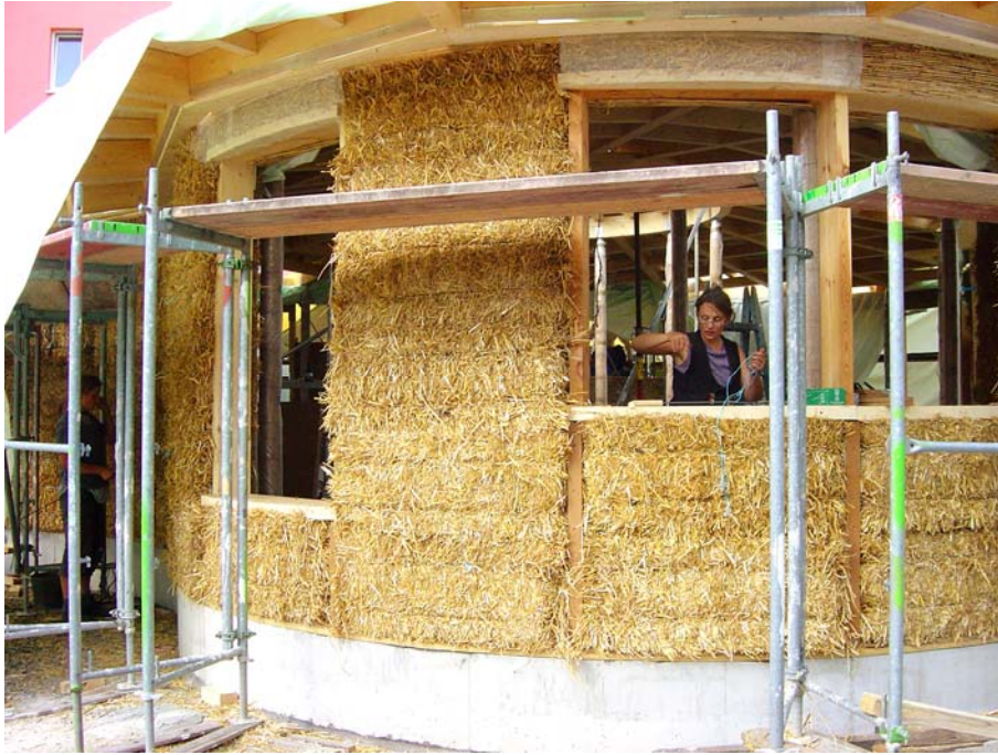
Die fertige Strohballenwand vor dem Verputzen
