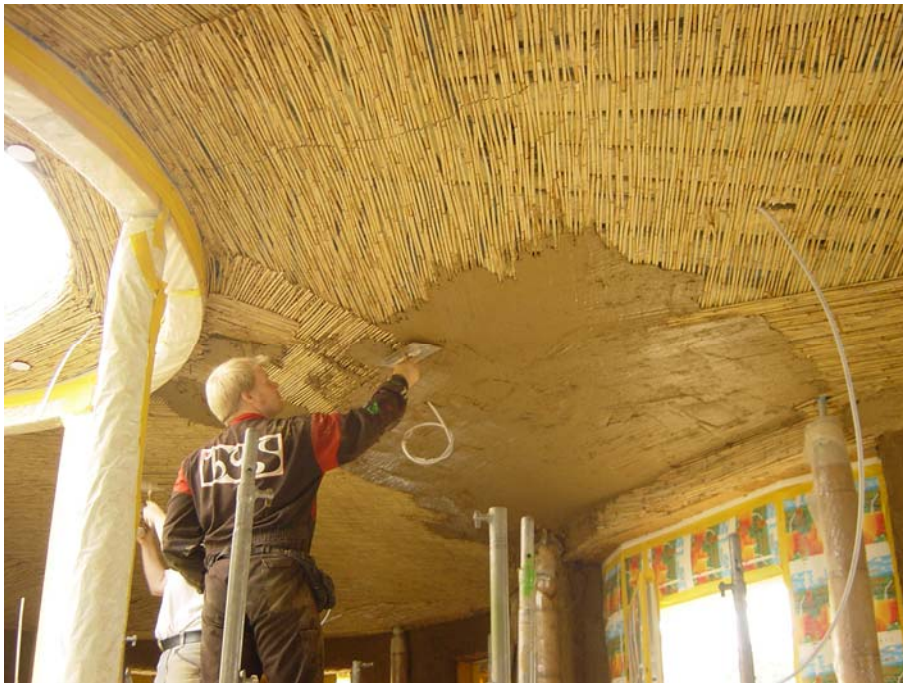
Der Lehmputz wird auf die Schilfrohmatten an der Decke aufgetragen, hinter denen sich die Hanfdämmung für das Dach befindet.
