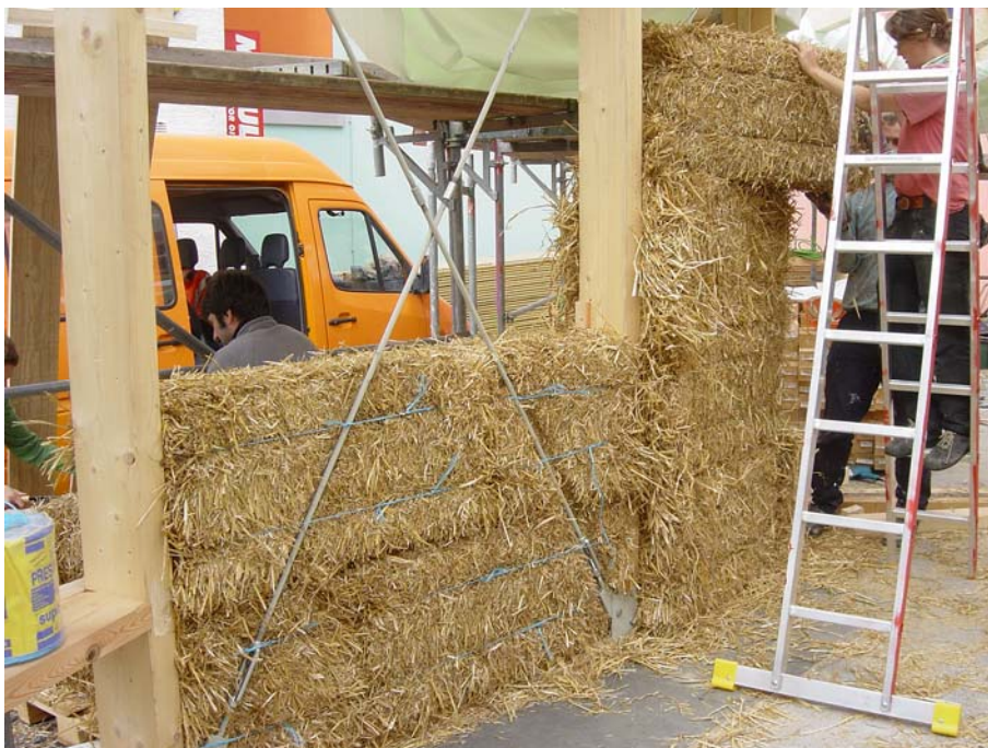
Gerade wird ein Ballen in die Konstruktion geschoben
