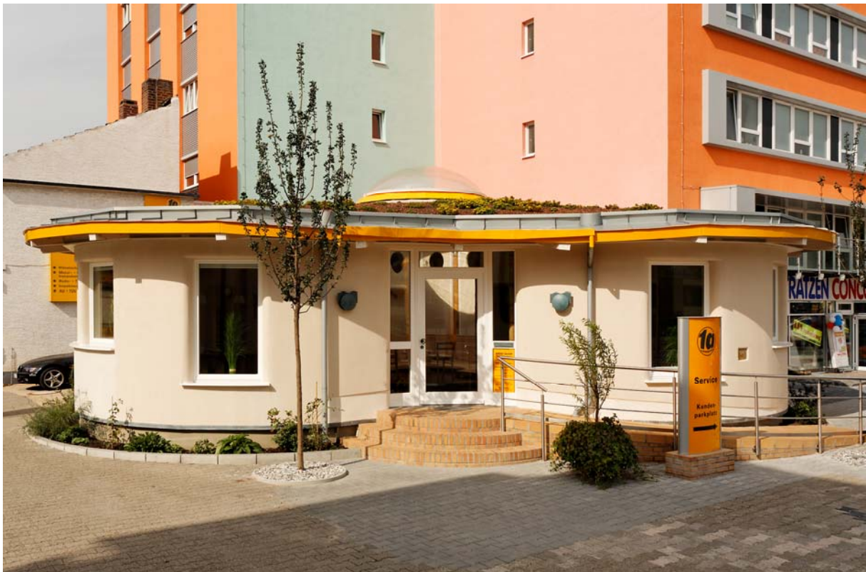
Lädt ein und macht neugierig: sanft geschwungene Fassade
