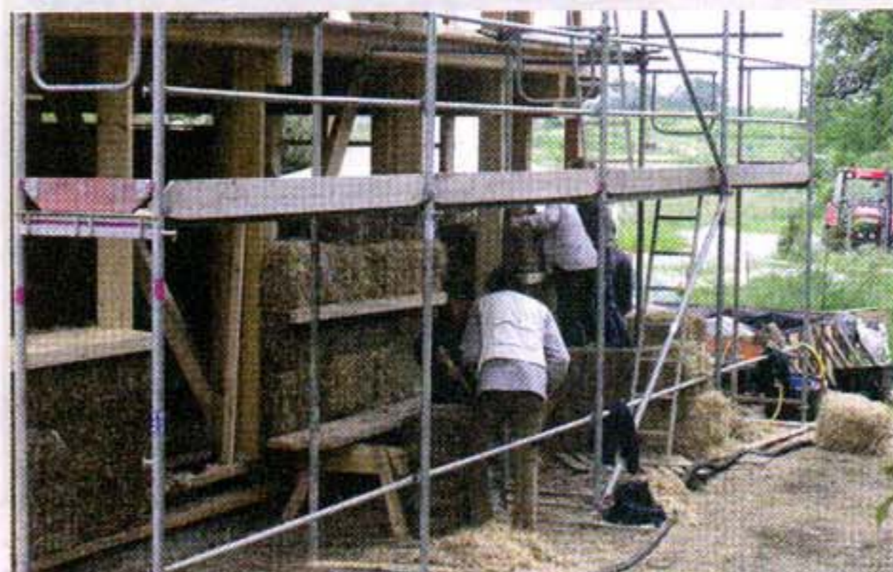
Bei der Holzständerkonstruktion werden Strohballen als Wand bildender Dämmstoff eingesetzt.
